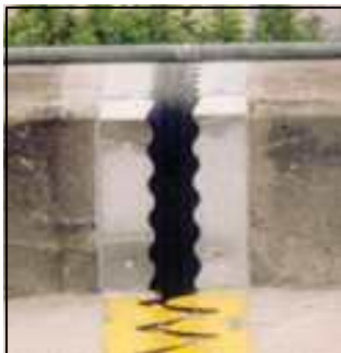
c. 설치 전경(내측)
